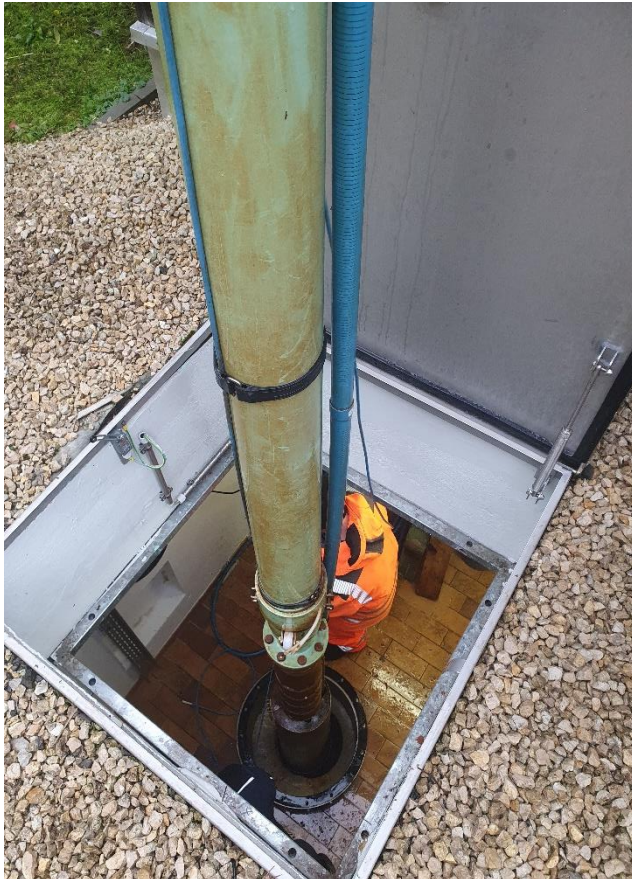
Ausbau Brunnenpumpe
